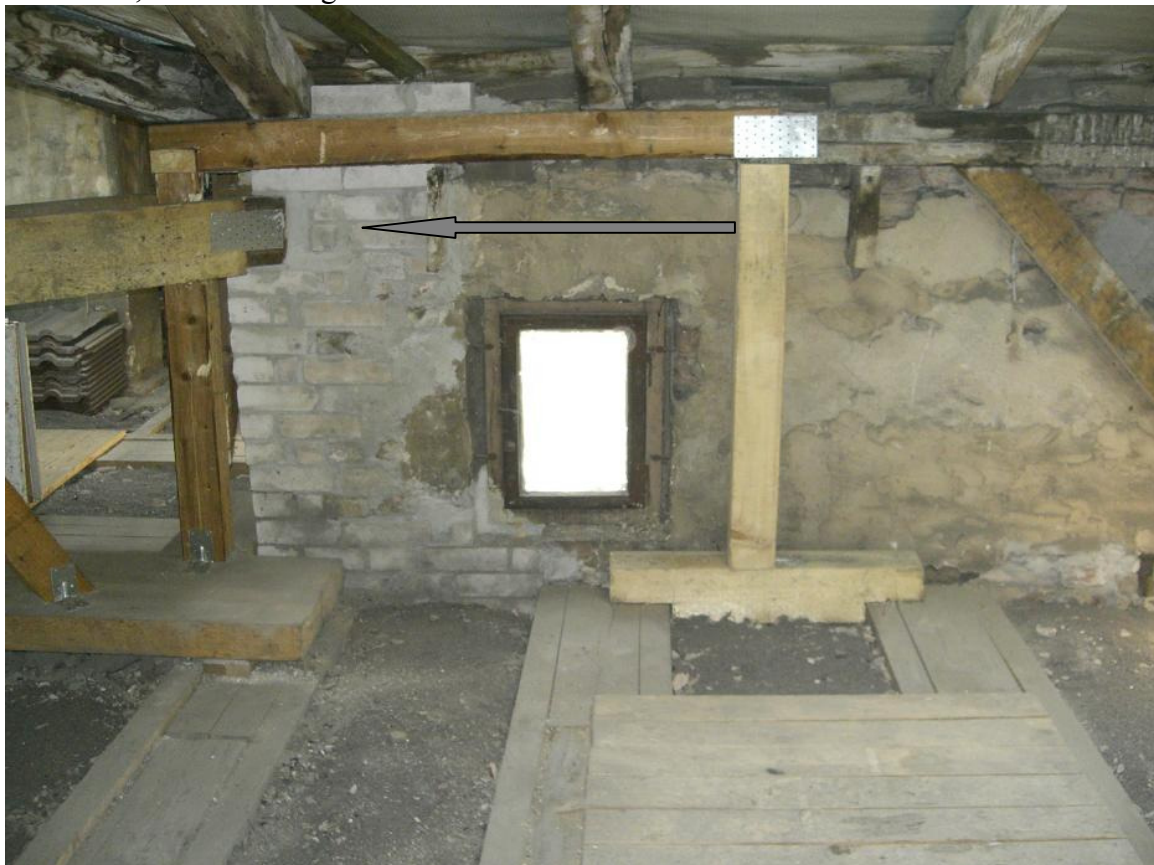
Dachstuhl, z.T. neue Tragkonstruktion
